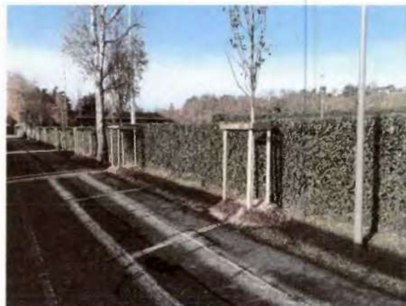
Arbres sur l'allée terrains de foot et rugby
